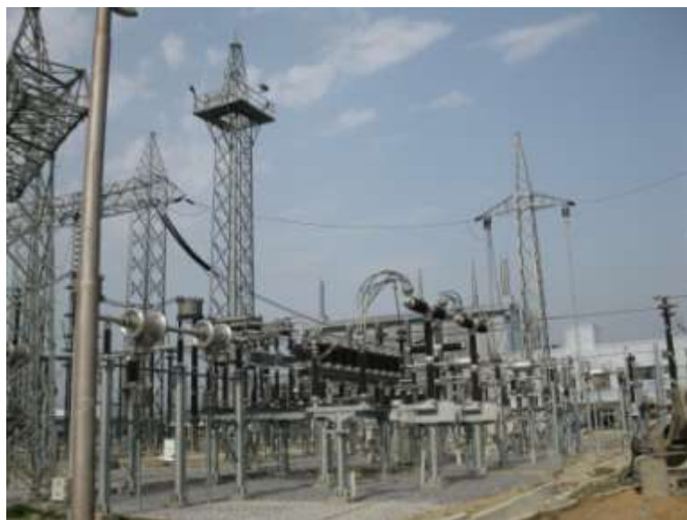
Фото 4: Конверторная подстанция
