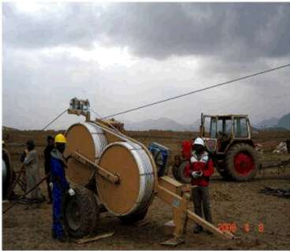
Фото 2: Строительство линий электропередач – прокладка проводов
